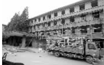
省医院老急诊楼被拆除
