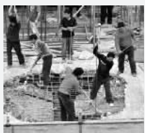
工人在楼顶拆除违章建设楼层
