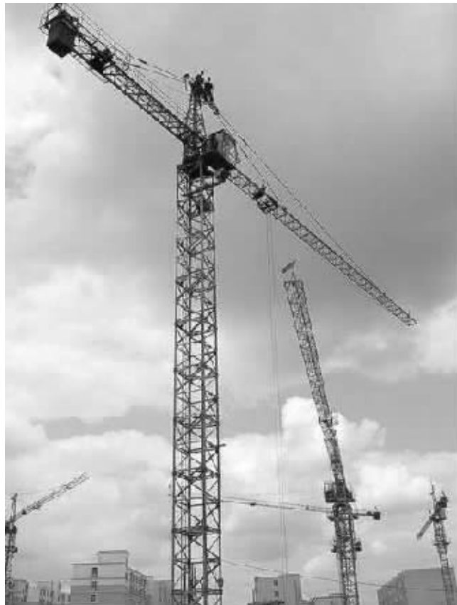
和顺皇冠假日酒店的施工现场
