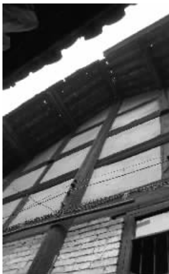
成都明代“猫猫庙”的木结构穿斗房屋
