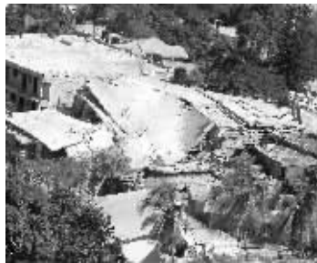
太子港在地震中受损建筑物 新华社发
