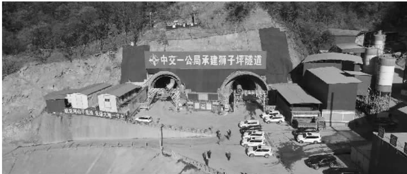
狮子坪特长隧道施工现场
