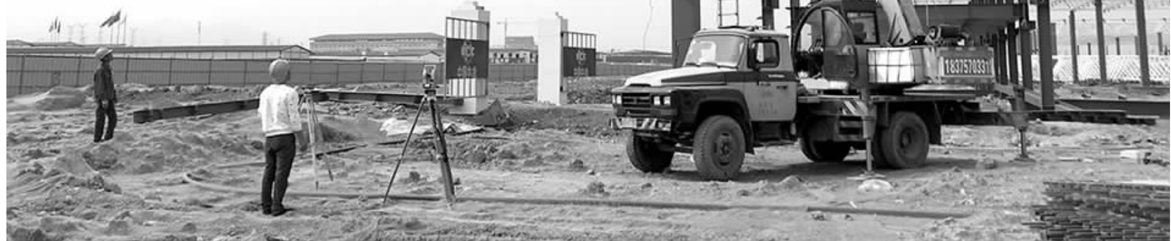
项目建设现场
