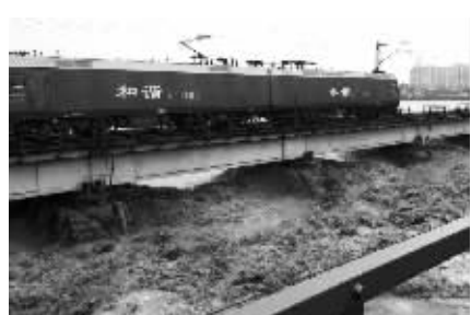
重载货物列车上桥,实施“重车压梁”
